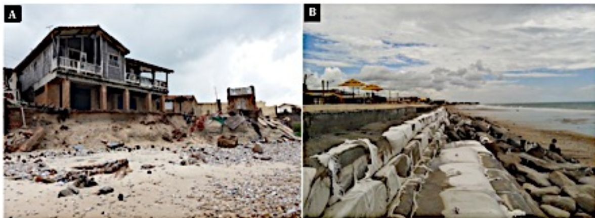
Figura 5. Situação de alguns pontos da praia do Icarai no município de Caucaia. Casa comprometida pela ação do mar (A); Estrutura tipo Bagwall que se estende por 1,5 km da praia (B).
